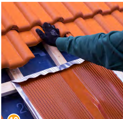
10 Disfare la copertura del tetto sopra il pannello Beta.
