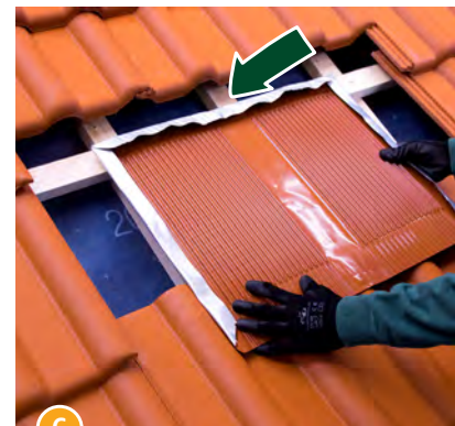
6 Posizionare l'apertura della lamiera di supporto sul listello trasversale superiore .
