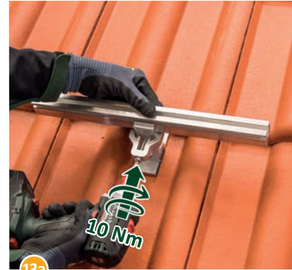
13a Stringere saldamente la combinazione a incastro con la vite (10 Nm ± 0,5 Nm) - fatto!
