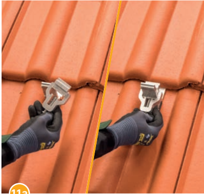
11a Applicare la combinazione a incastro orizzontale al supporto.
