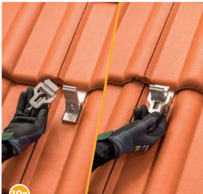
10a Applicare la combinazione a incastro orizzontale al supporto.
