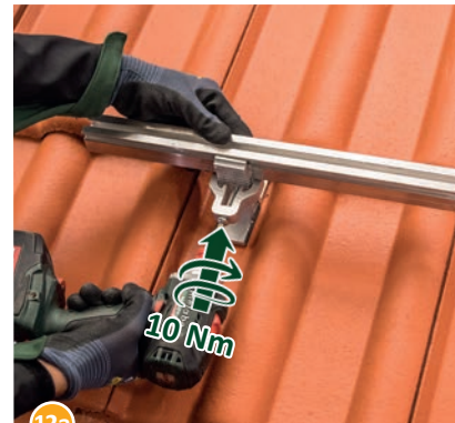
12a Stringere saldamente la combinazione a incastro con la vite (10 Nm \pm 0,5 Nm) - fatto!
