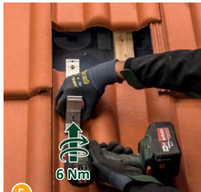
5 Avvitare saldamente il supporto (6 Nm \pm 0,5 Nm).
